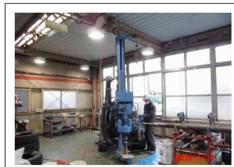
ボーリング調査
