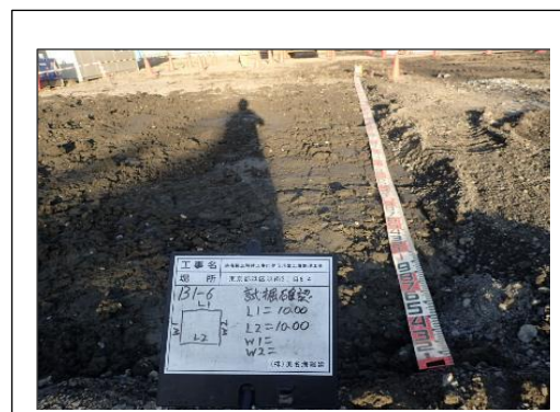
掘削場所の長さ計測
