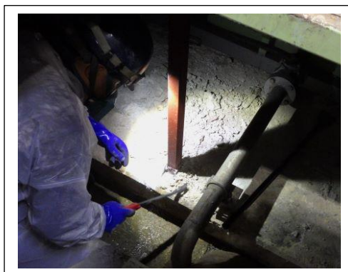
結晶化産廃の除去作業
